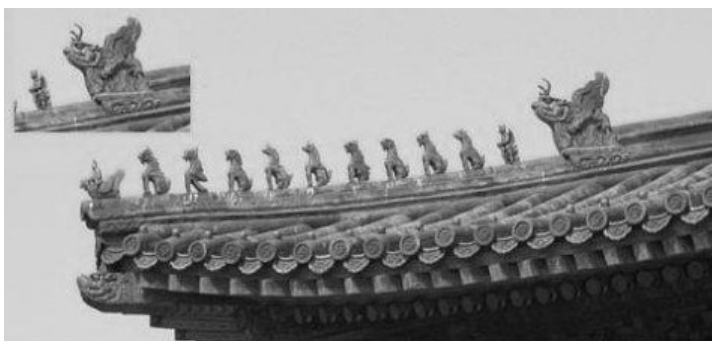
图 1-1 古代建筑中动物状的瓦饰起到避雷作用
