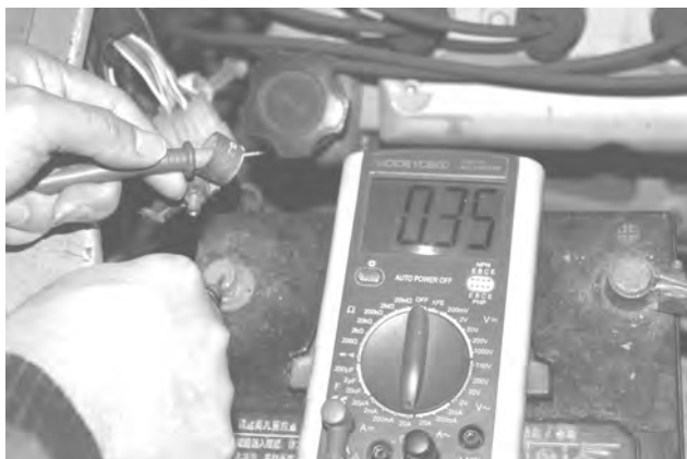
图 1-1-4 漏电电流检查
